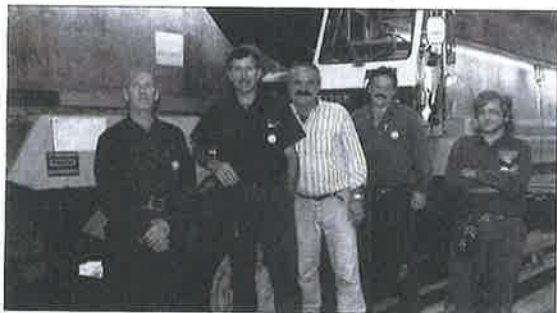
L'équipe de MTB, soit Fernand Lévesque, Gilles L'Espérance, François Simard et Raymond Mayer, qui entoure Wilfrid Fournier de Janin Construction, complètera l'installation des nouvelles barres de guidage aux garages Saint-Charles et Beaugrand.
